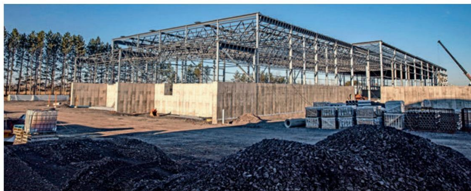
Selon l'échéancier, le site devrait être fonctionnel le printemps prochain. Sur la photo, on voit la structure de l'usine présentement en construction. Photo: Le Canada Français - Jessyca Viens Gaboriau
